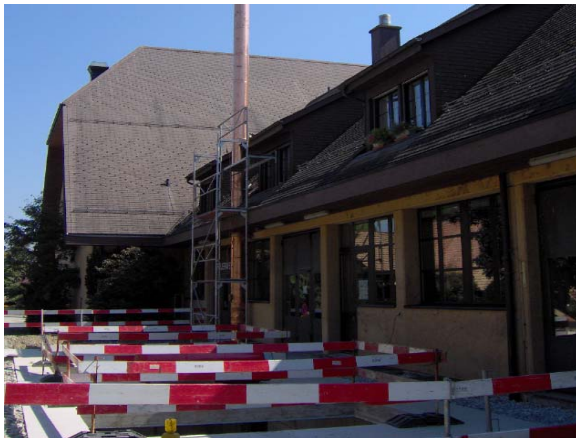
Zentrale mit Silo und Abgasanlage
